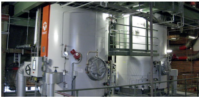
Elektrodenkessel im Heizkraftwerk des Industrieparks Höchst, Frankfurt Foto: Infraser GmbH & Co. Höchst KG
