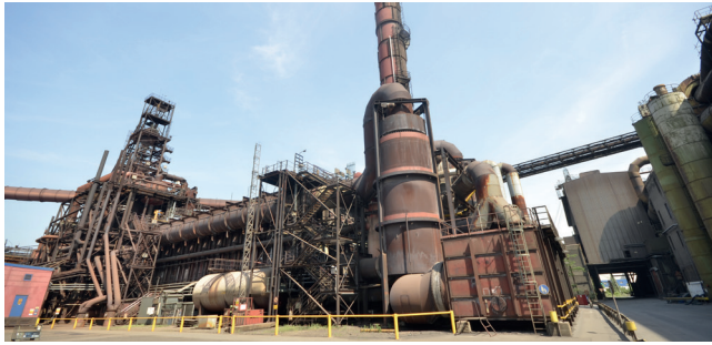
Erdgasbasierte Direktreduktionsanlage, Stahlwerk Hamburg, ArcelorMittal
