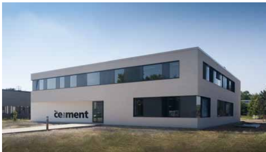
Рис.1. Здание опытно-промышленной установки по производству целитемента
